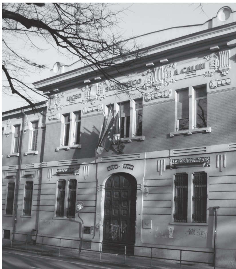
La Provincia, prima dell'addio, mette mano ad alcune importanti opere di ristrutturazione nelle scuole superiori
