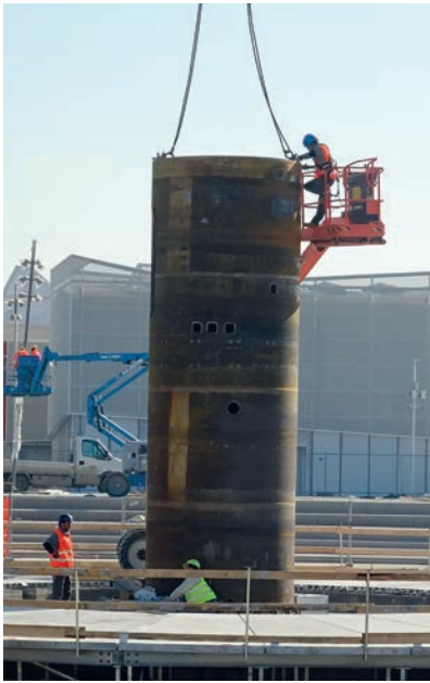
Il montaggio della struttura centrale
