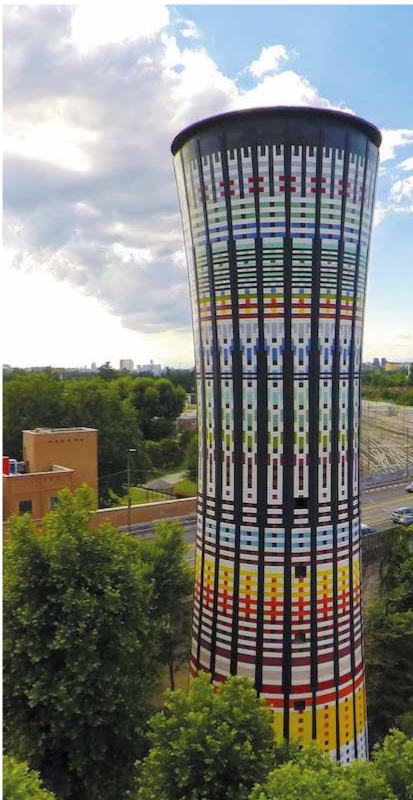
La torre Arcobaleno è stata ristrutturata in occasione di Expo con la partecipazione di Mapei
