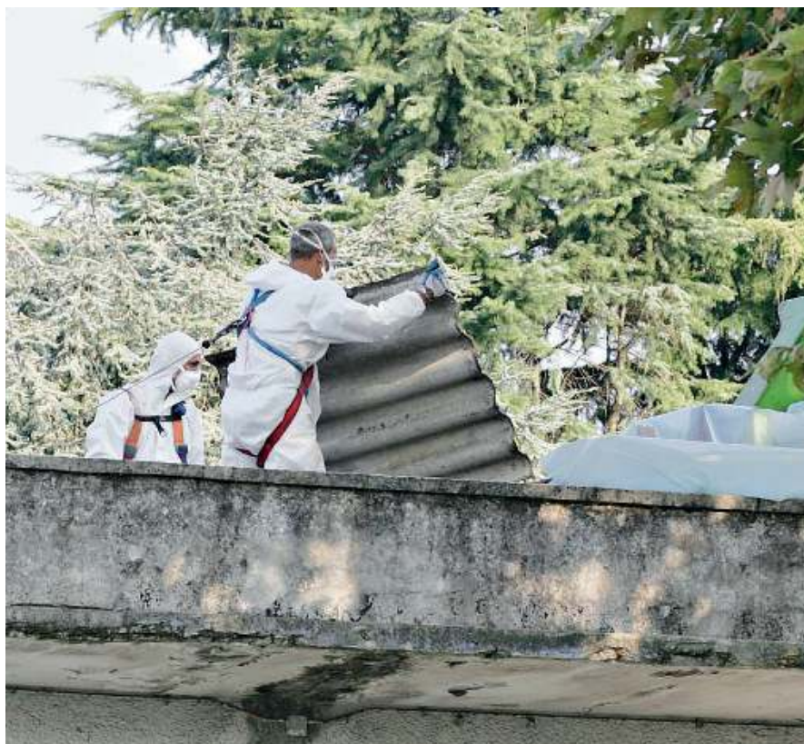
Al lavoro. Operai impegnati nella rimozione di lastre contenenti amianto
