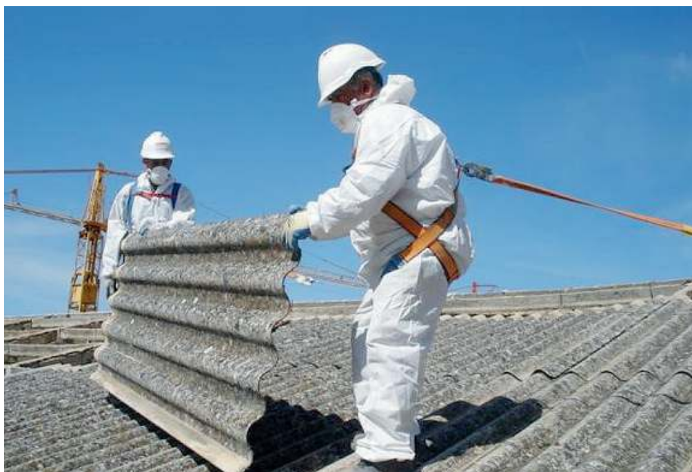
Sui tetti. Al lavoro per togliere lastre di amianto. Nel Bresciano ne restano da rimuovere oltre 20 milioni di metri
