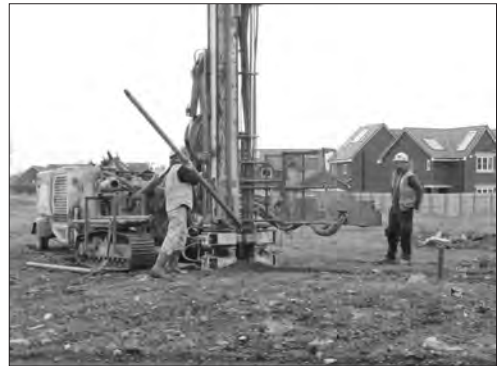
Inserimento e montaggio asta di perforazione
