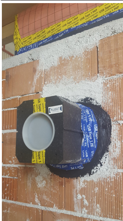
Dettaglio del posizionamento del canale di uscita della ventilazione meccanica controllata, sigillato e nastrato a regola d'arte per una tenuta all'aria corretta
