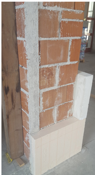
Corretto posizionamento negli angoli dei pannelli isolanti necessari per la coibentazione delle parti verticali
