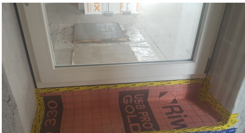
Dettaglio delle nastrature per la corretta realizzazione della tenuta all'aria del sottodavanzale
