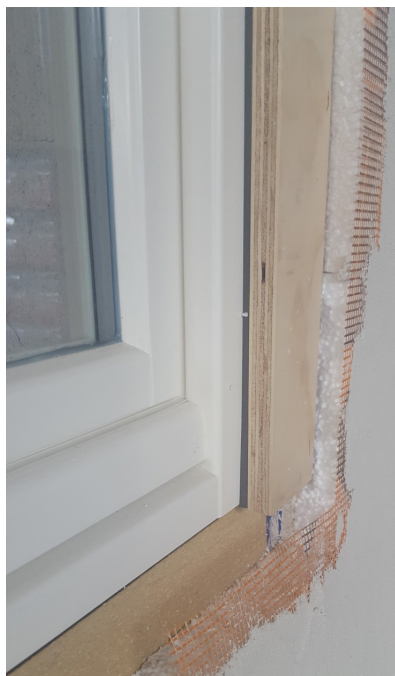
Sormonto dello strato isolante sul falsotelaio del serramento posizionato a filo esterno della muratura, con dettaglio della rete di armatura necessaria per una corretta rasatura superficiale di finitura
