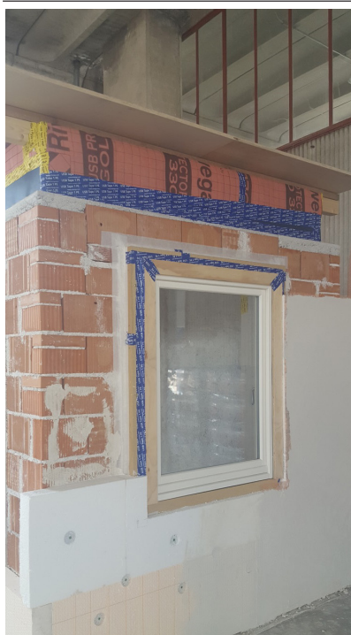
Realizzazione prototipo casa passiva durante la parte pratica del corso Passivhaus dedicato agli operatori edili, presso il laboratorio ESEB di Brescia
