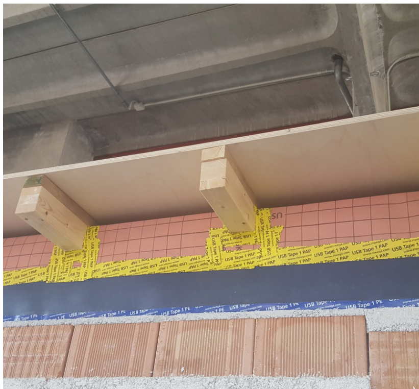
Dettaglio delle nastrature per la corretta realizzazione della tenuta all'aria del solaio di copertura in legno
