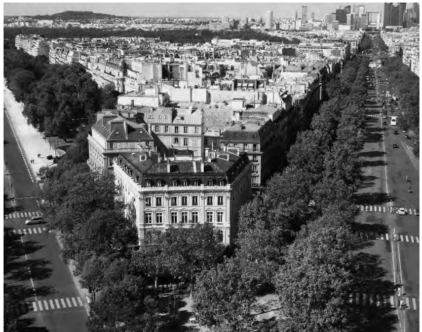
Con il piano di rilancio varato dal Governo francese, l'edilizia è tornata a valori di alta produttività
