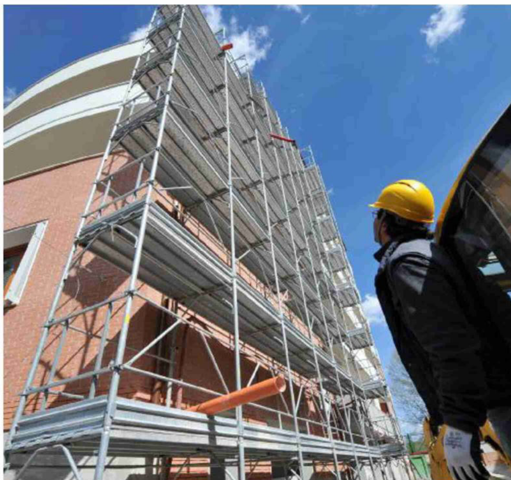
Cantiere edile Ritardi nelle forniture potrebbero compromettere il cronoprogramma dei lavori
