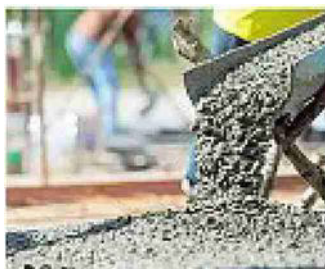
Calcestruzzo In un cantiere edile
