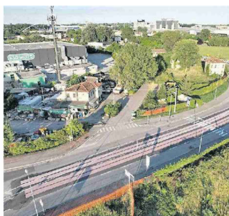
I LAVORI Concluse le opere, ora si installano impianti e sistemi
