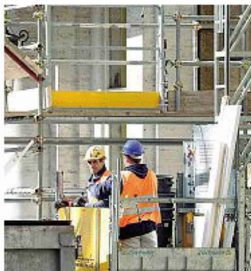
Operai al lavoro in un cantiere
