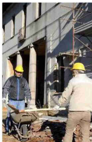
Operai in cantiere
