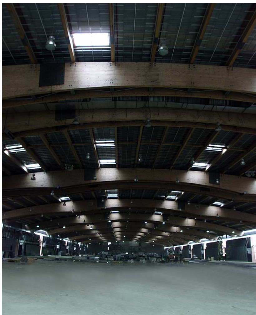
L'interno del primo padiglione espositivo realizzato a Chiesanuova
