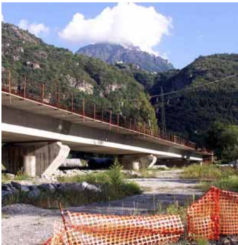
Un cantiere sulla 510, una delle strade in attesa di completamento
