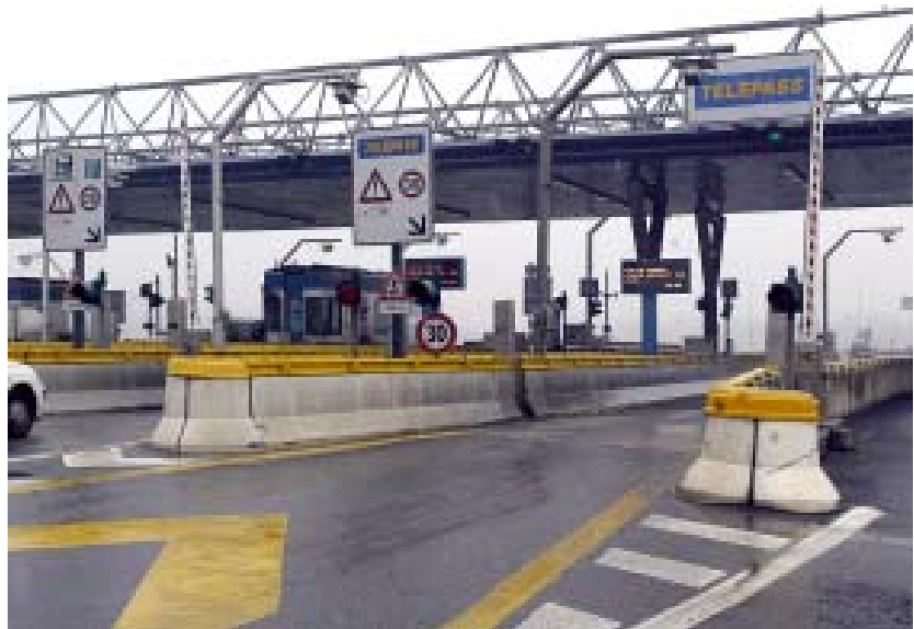
Al casello di Brescia-Est verrà presto realizzata l'area attrezzata per ospitare i Tir
