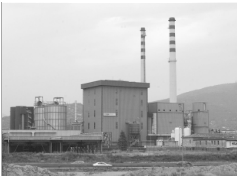
La centrale del teleriscaldamento di via Lamarmora
