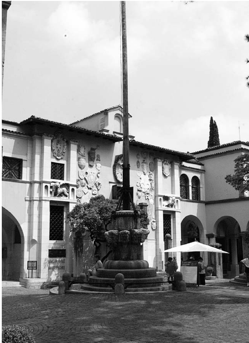
L'ingresso della Prioria che fu l'abitazione del Poeta
