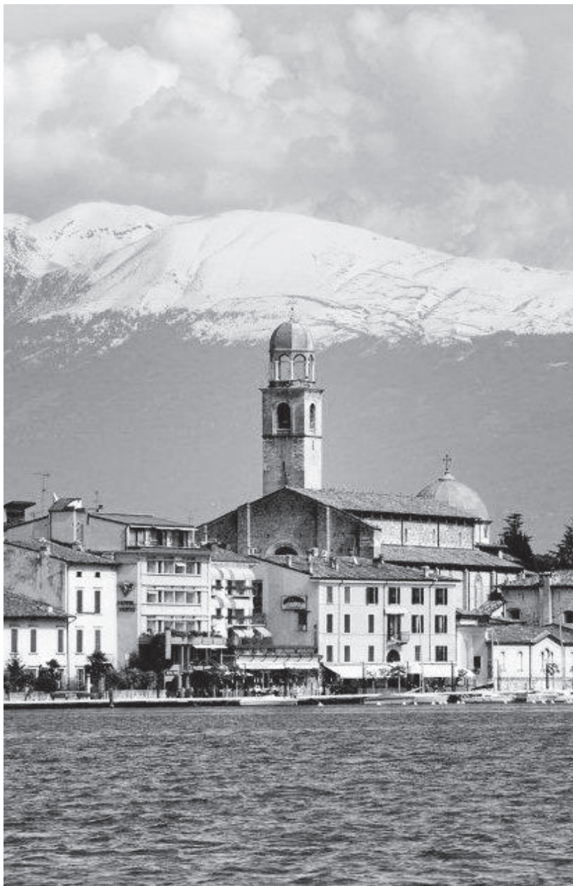
Salò rientra nel progetto di depurazione in collegamento con la Bassa
