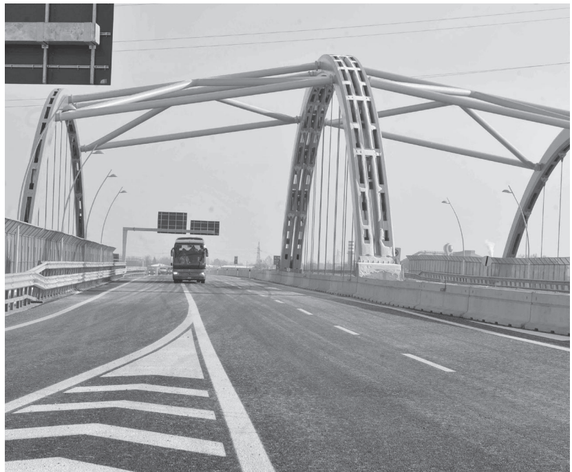
Un viadotto della nuova Corda Molle: l'infrastruttura che collega Azzano Mella a Castenedolo
