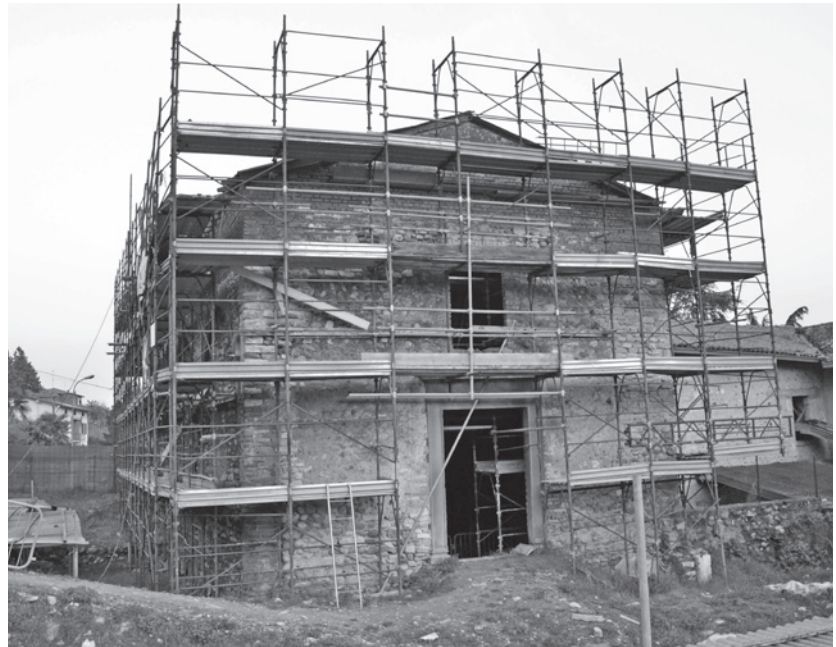
Nella foto i lavori di restauro che hanno interessato la copertura della Pieve di Bornato
