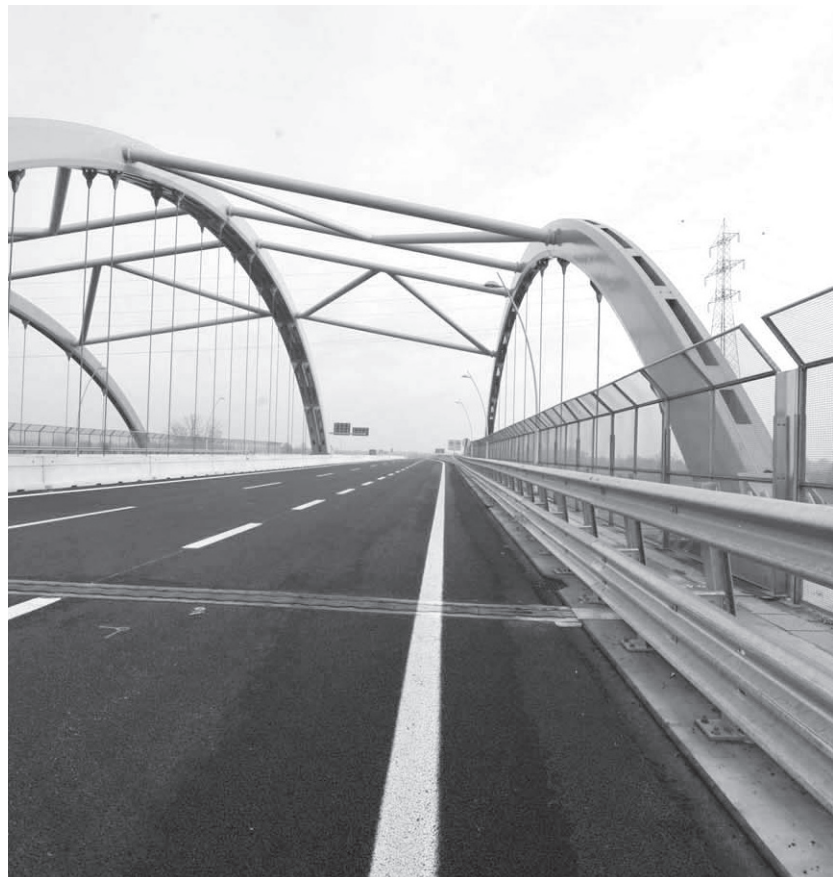
Il simbolo architettonico della Corda Molle è il viadotto sulla Brescia-Cremona
