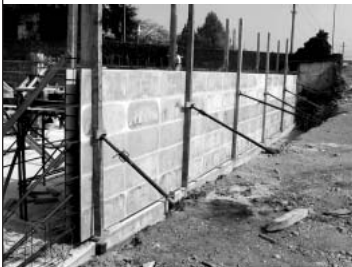
ESEMPIO DI MURATURA CON CASSERI SMOL
