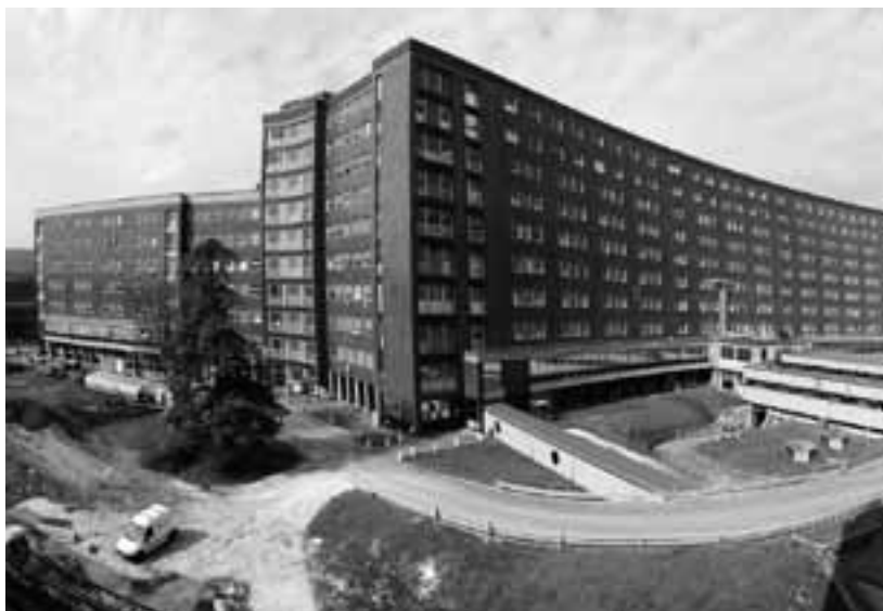
Gli Spedali Civili sono sottoposti ad un corposo intervento di ristrutturazione
