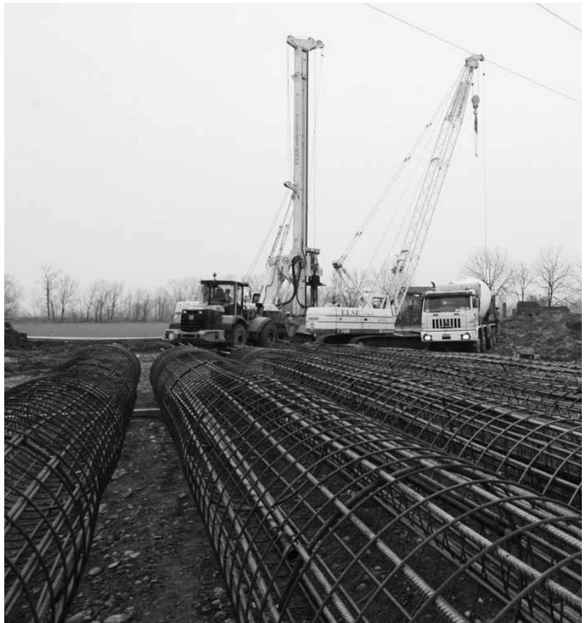
Un cantiere per la realizzazione della direttissima Brescia-Bergamo-Milano
