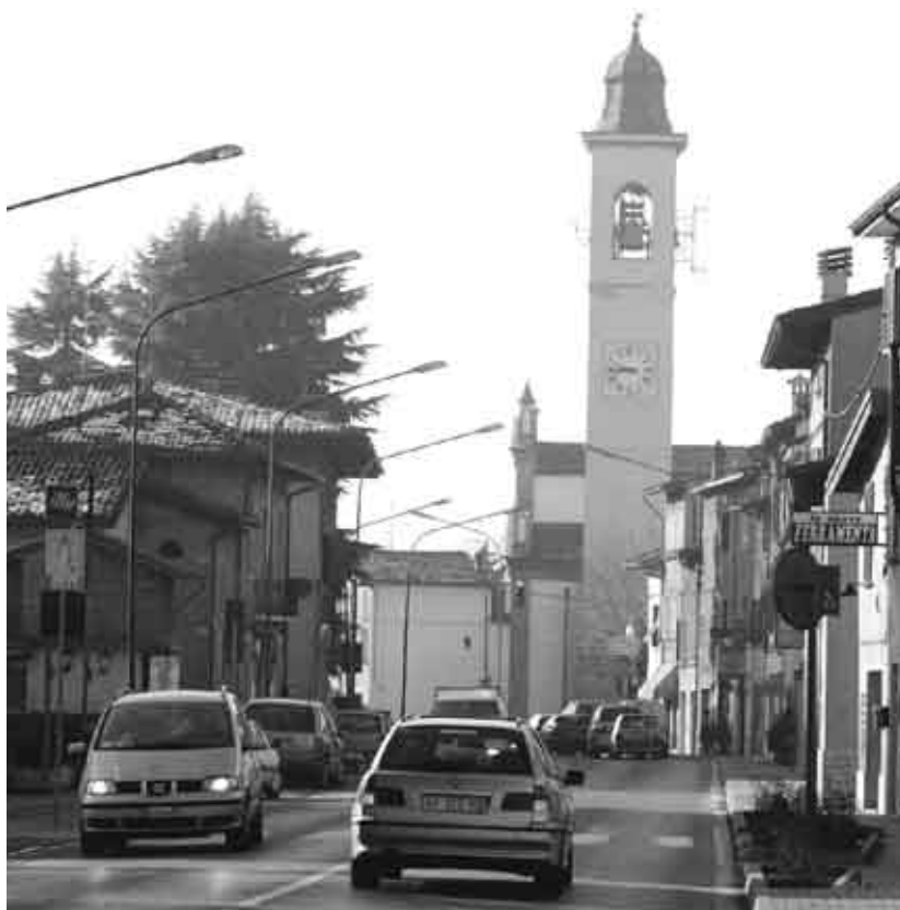
Il centro di San Zeno è caratterizzato da evidenti problemi di traffico
